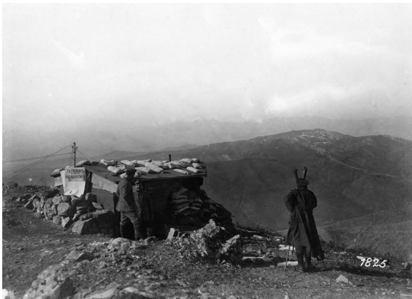
Българска телефонна станция с окопен перископ за наблюдаване на вражеските позиции в предната част на Дойран, март 1917 г.
